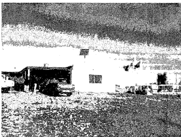
写真 5 地方小学校(中央が太陽電池パネル)
