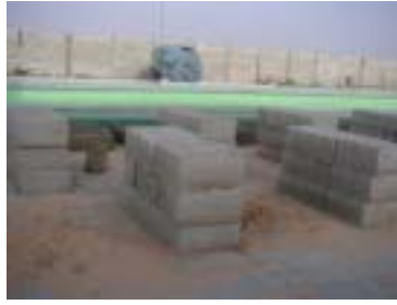
Bloc en béton NKC 1
