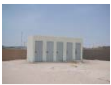
Bloc de latrines NDB
