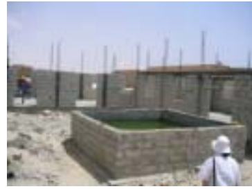
Chantier de construction DB 2
