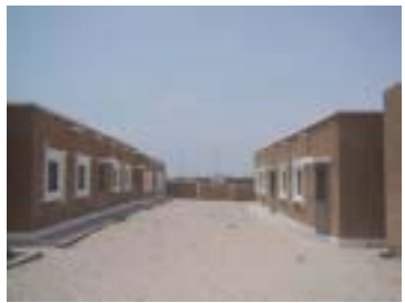
Bloc de salles de classe d'une nouvelle école fondamentale NDB 1
