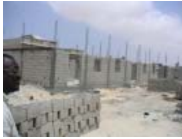
Chantier de construction NDB 1
