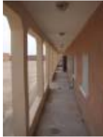
Véranda de bloc de salles de classe
