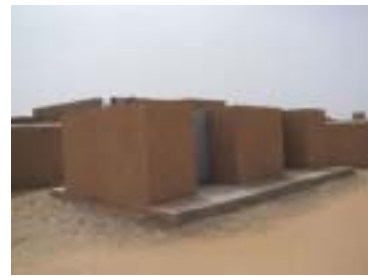
Bloc de latrines ( 8 cabinets )
