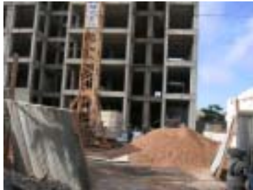
Chantier de construction NKC 1
