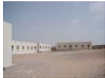
Bloc de salles de classe d'une nouvelle école fondamentale NDB 2
