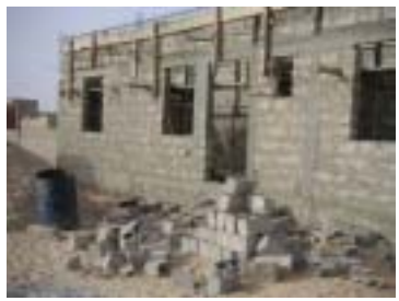
Chantier de construction NKC 2
