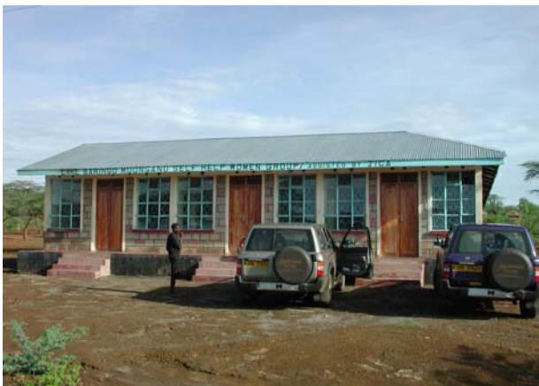
実証調査(小規模産業振興)で建設された施設
