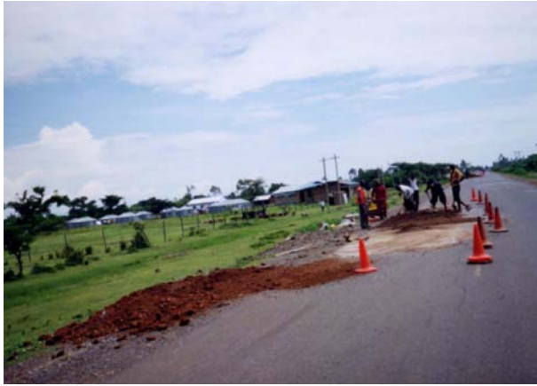
幹線道路の補修作業風景
