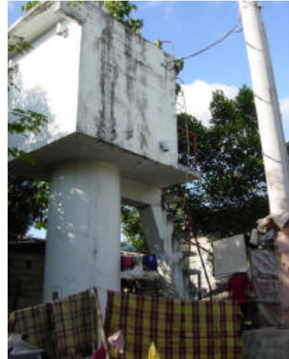
観測所 (水位計はフロートタイプ)
