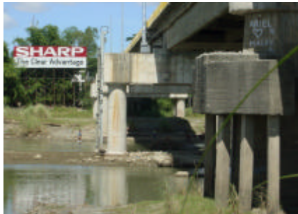
新しい橋脚にセンシングポールを移設
