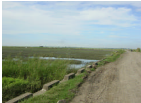
雨期には冠水する道路
