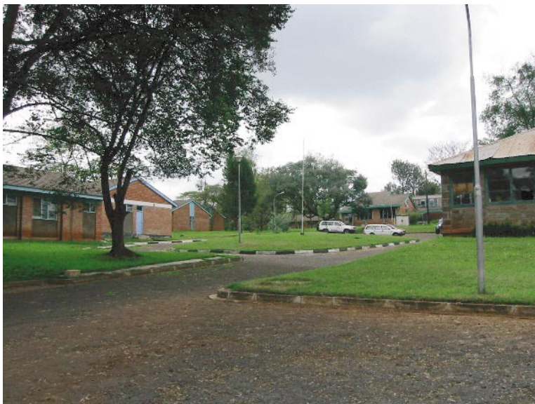
フェーズIIから新たに中央研修施設として提供された技術教育センター (Centre for Research and Training in Karen)
