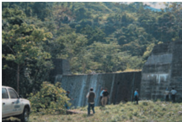
「チョロマ川洪水対策・砂防計画」による砂防ダム
