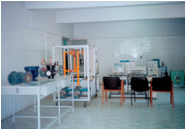
エジプト「水道技術訓練向上計画」。施設内の様子。
