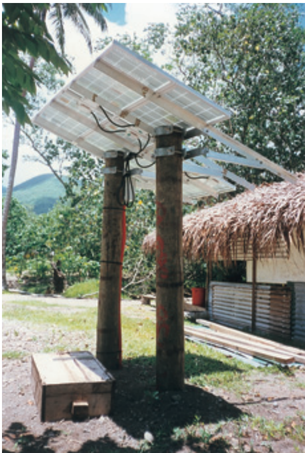
バヌアツ「地方電化プロジェクト」による太陽光発電システム。
