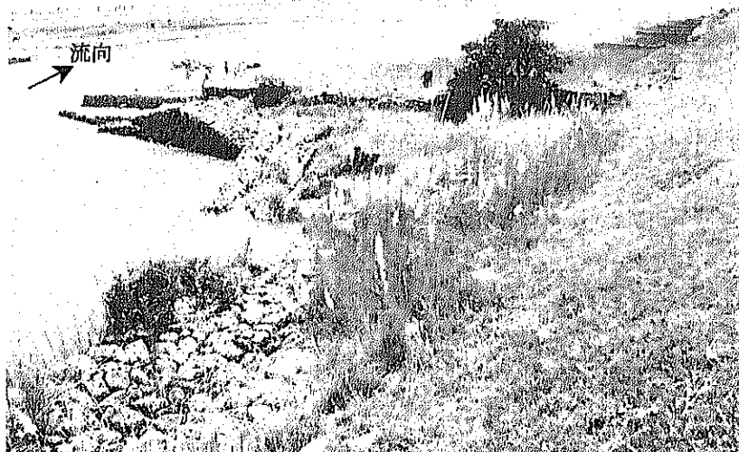
写真 9: Mechi 川(東部) 水制工の設置によりみお すじが中央に移動。下流 部には水制工群が設置さ れている(写真右上)。
