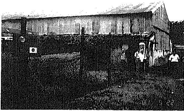
蛇籠編機工場全景
