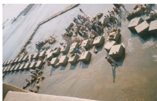
写真 4.3 フリクションブロックの被害
