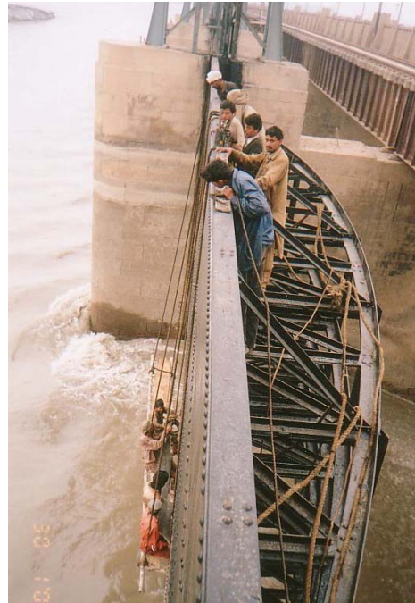
写真 4.17 ゲート補修
