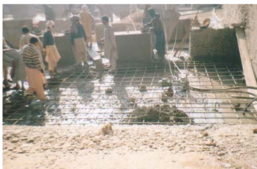
写真 4.4 スキンコンクリートの修復工事
