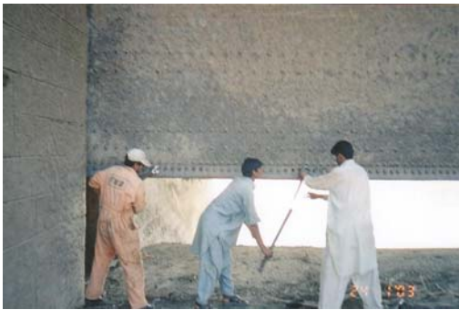
写真 4.16 ゲート底部戸当り補修
