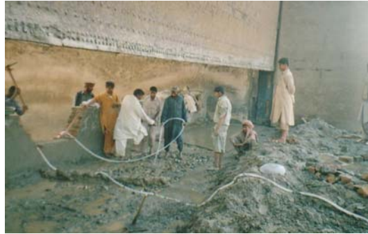
写真 4.15 堰クレスト部補修
