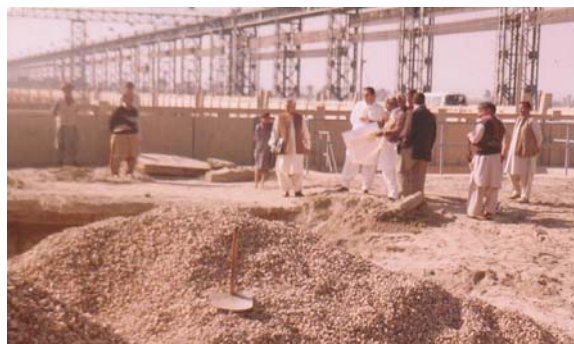
写真 4.14 左岸アバット陥没部修復工事
