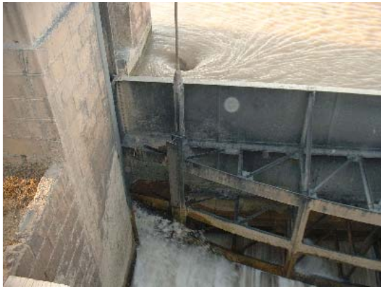
写真 4.20 洪水吐ゲート両脇の渦の状況
