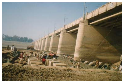
写真 4.7 修復工事用コフファードム
