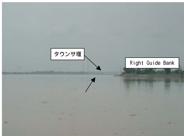
写真-3 タウンサ堰上流右岸側から下流方向
