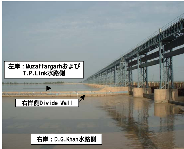
写真-1 タウンサ堰上流側
