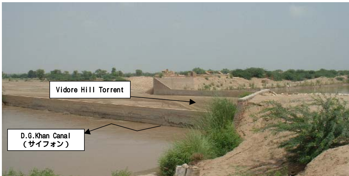
写真-9 D.G.Khan水路を横断するVidore Hill Torrent
