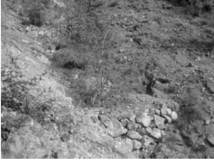
8. Yalancı Akasya dikilmiş küçük bir kontrol barajı
