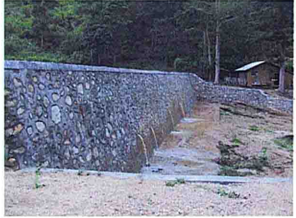
ボネ川支川の土砂貯め施設
