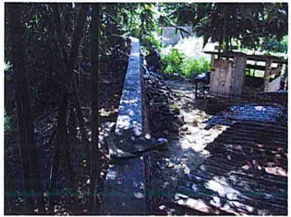
Bolaongo 川 既設堤防
