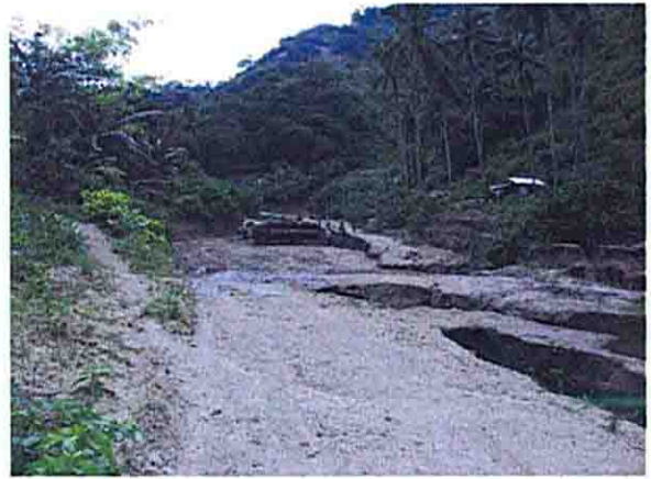
ボネ川支川の土砂貯め施設での土砂採取状況
