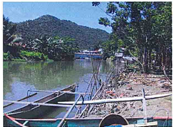
ボランゴ川無堤部
