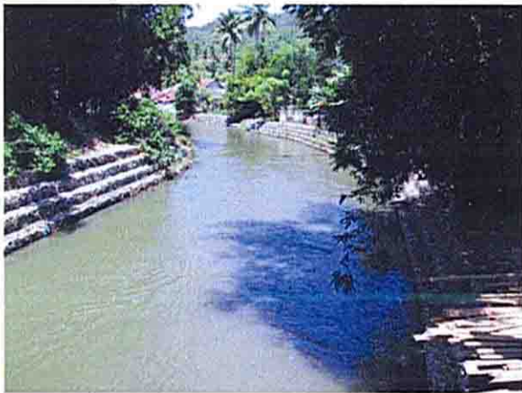
Bolaongo 川既設蛇籠護岸
