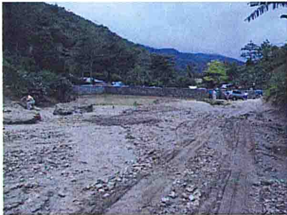
ボネ川支川の土砂貯め施設（上流から）
