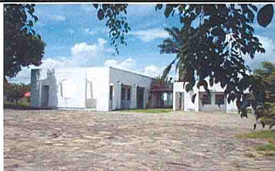
モクバ訓練センター - 教室棟及び実習棟
