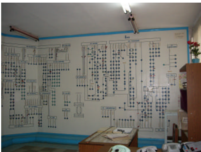
CHIRONZOR 運転指令所 系統盤
