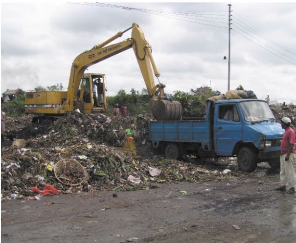
Matuail処分場でのゴミ排出状況（その2）
