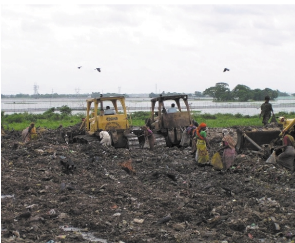
Matuail処分場での重機によるゴミ敷き均し 状況とウェイトピッカー
