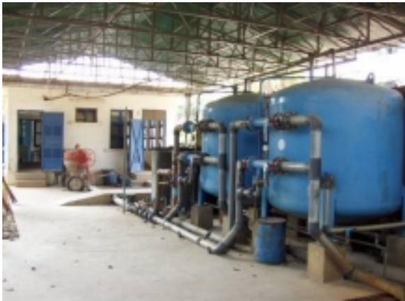
写真7：急速ろ過タンク2基
