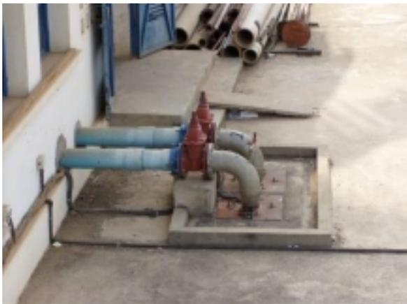
写真9：高架水槽への送水水中ポンプ
