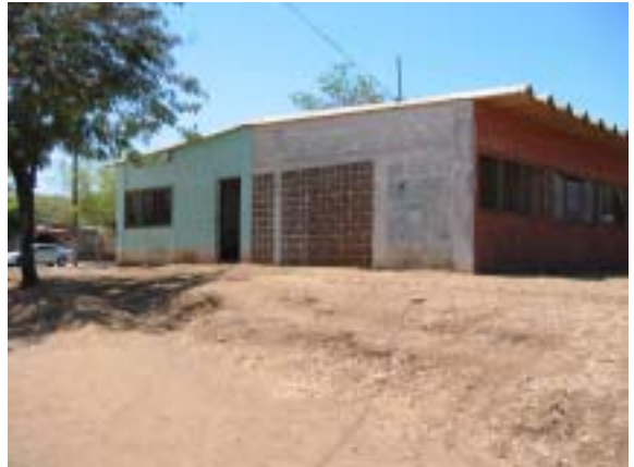
既存施設現況 東側 外観 消防署が隣接している
