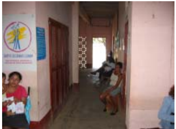
既存施設現況 待合から中廊下
