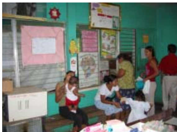
既存施設現況 主出入口内部 待合、受付け
