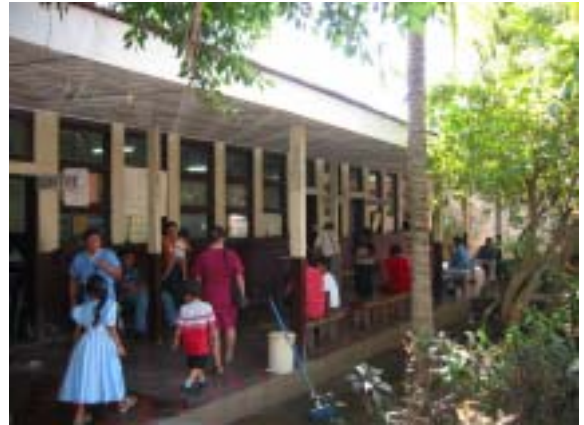
既存施設現況 外来部 外観
