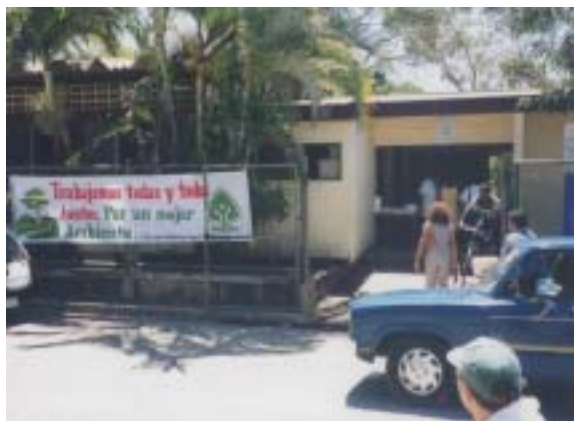
既存施設現況 北側 主出入口 外観 敷地に増築の余裕はない
