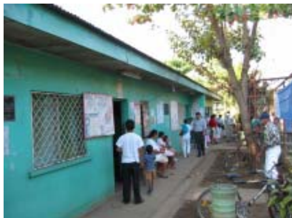
既存施設現況 主出入口部の外観
