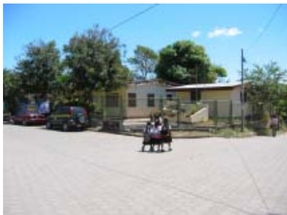
既存施設現況 西側道路より東方向 外観 中央広場に面する
