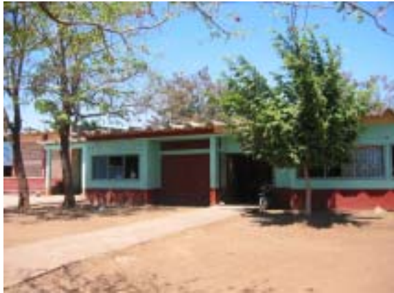
既存施設現況 南側正面 外観 市の公民館の一部を借り受けている
