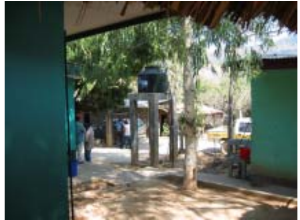
南側敷地内の給水タンク 恒常的な水源不足により給水制限されている
