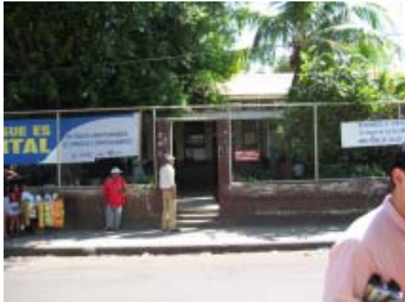
既存施設現況 北側 正面外観
