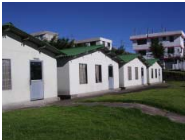
既存校舎は DINSE 標準仕様の鉄骨造構造体、仕上ともに健全な状態である
