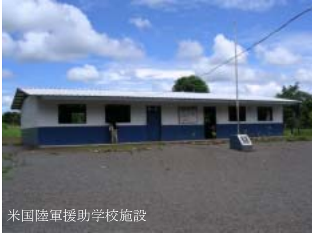
同 軒部鉄骨下地+カラー鉄板
