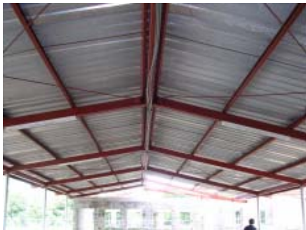
教室棟屋根小屋組 軽量鉄骨+カラー鉄板
