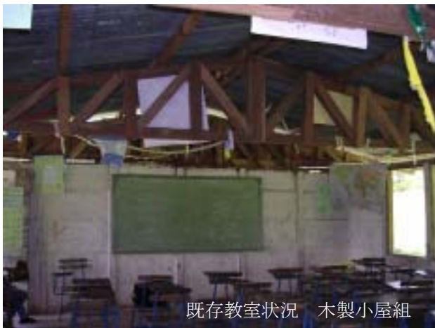
妻側壁コンクリートパネル、開口部
