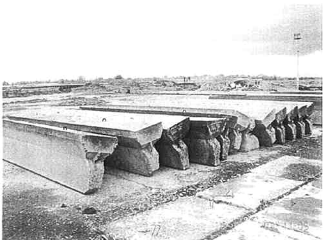
ウズベキスタン道路公社 サマルカンド州支部アフロシヨブ道路開発局 コンクリート製中央分離帯
