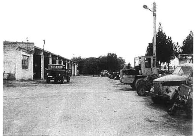
キトプAVTOYUL 機材置き場兼修理施設
