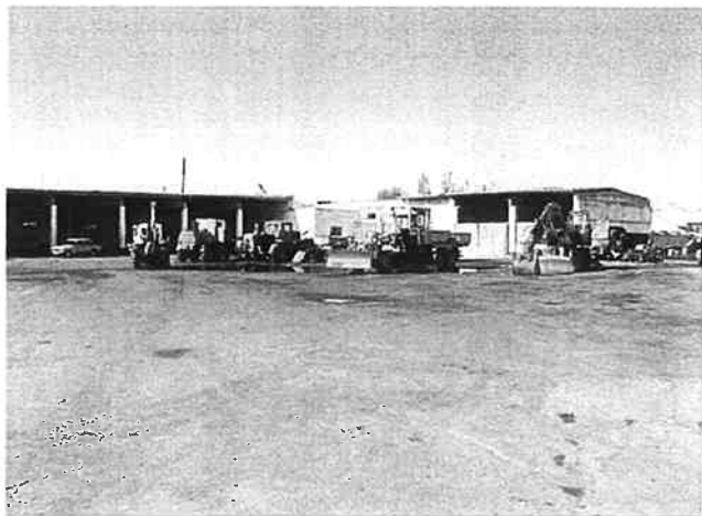
カシュカダリヤ州道路公社 カルシARO機材置き場及び修理工場
