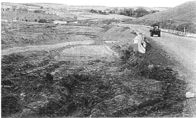
A378号線 カシュカダリヤ州管轄区間 拡幅工事現場
