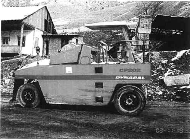
日本の無償援助にて調達された機材 タイヤローラー カムチック峠にて稼動中
