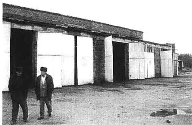
カタコルガン道路開発局 修理工場
