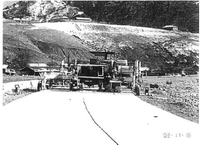
A373号線状況 コンクリート舗装工事箇所
