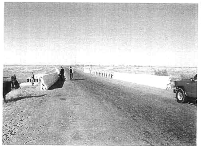
4P87号線道路 カシュカダリヤ州管轄 橋の状況
