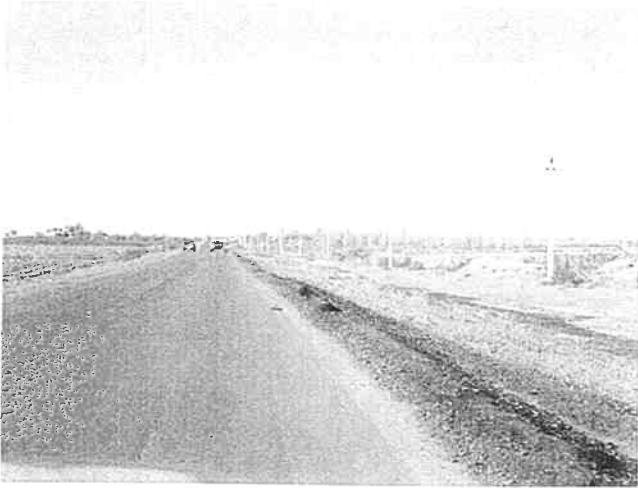
4P87号線の道路状況 カシュカダリヤ州管轄道路
