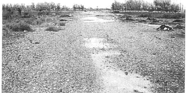
M37号線バイパス道路建設現場
