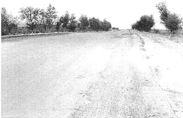
A378号線道路状況(新規要請区間) サマルカンド州管轄区間
