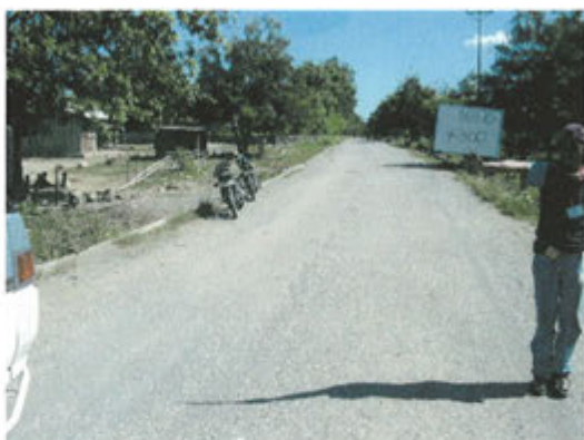
52) 道路状況 (STA168+300)
