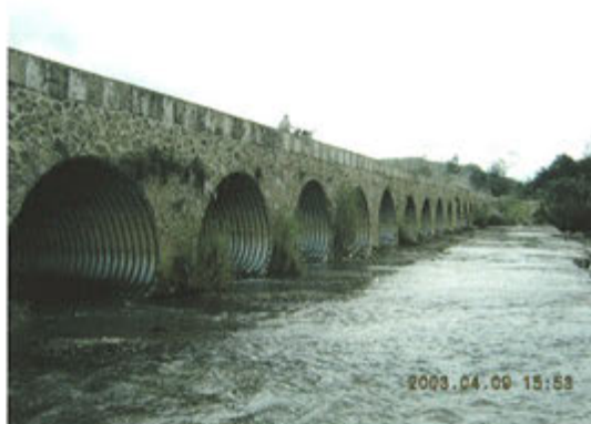
14) コルゲートパイプ橋 (STA49+000)
