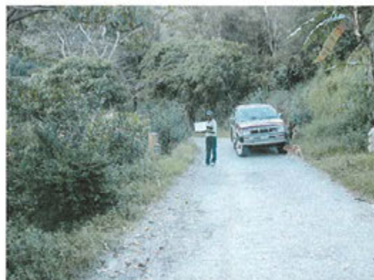
35) 道路状況 (STA102+000)
