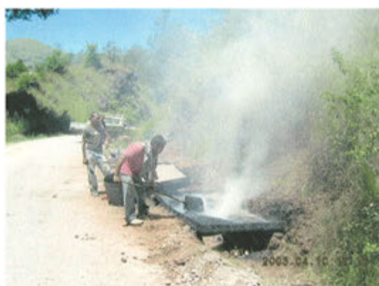
20) 舗装の補修作業 (STA72+300)
