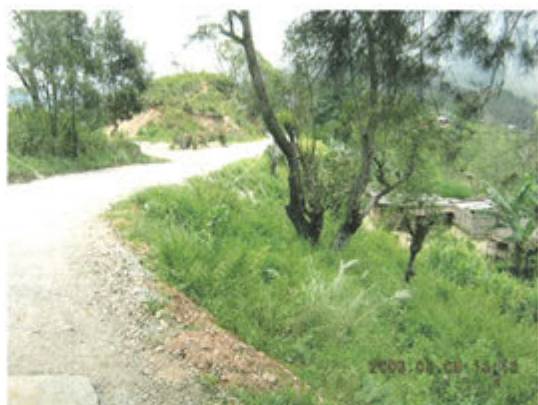
10) 路線状況 (STA39+500)
