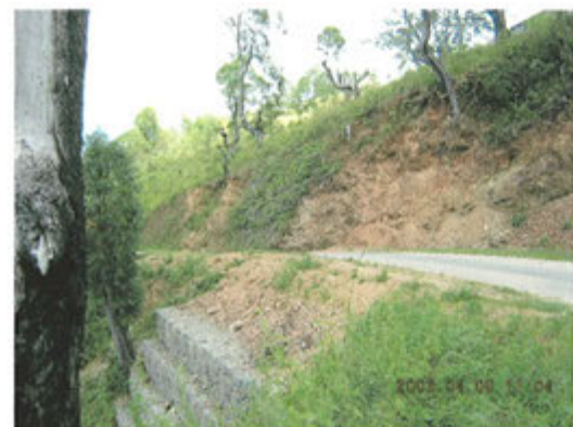
9) フトンカゴ設置状況 (STA40+500)
