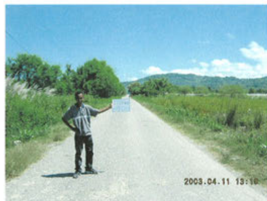
51) 道路状況 (STA160+000)
