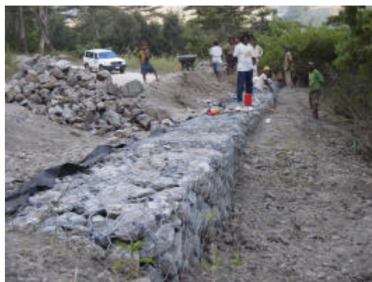
写真 - 2.2 ガビオン工 (km102 + 100)
