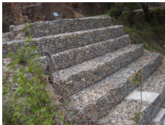
写真 - 2.4 法面防護工 (km40 + 500)
