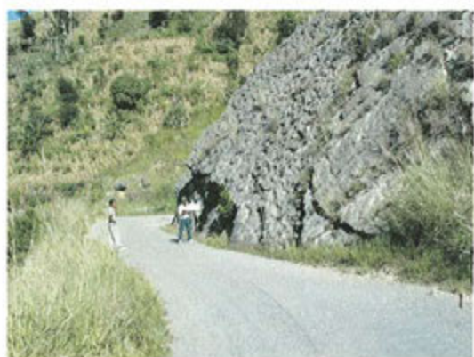
31) 岩盤露出箇所 (STA92+260)
