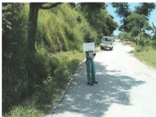
1) 道路状況 (STA8+100) (側溝なし)
