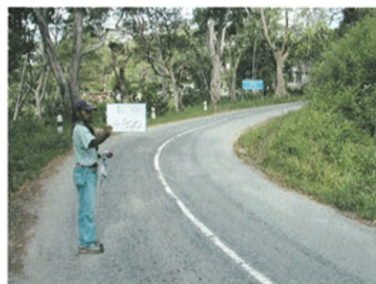
4) 道路状況 (STA12+800)(良好な状態)
