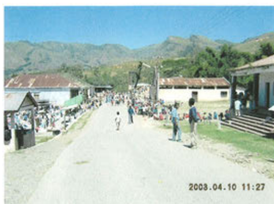
18) マウビセ街路状況 (STA71+300)
