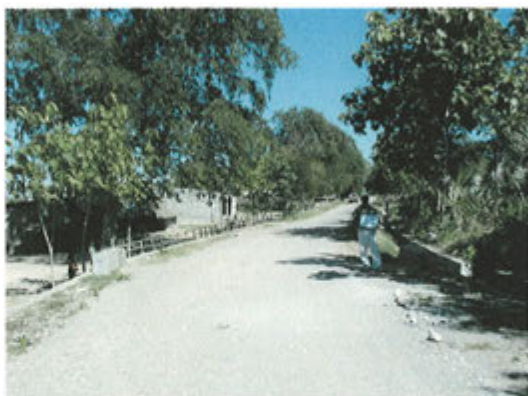
46) 道路状況 (STA142+600)
