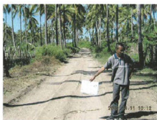
43) 道路状況 (STA130+100)
