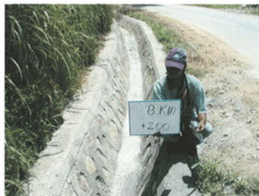
2) 練石積側溝 (STA8+200)
