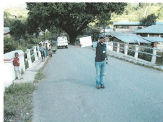
16) コンクリート橋 (STA59+600)
