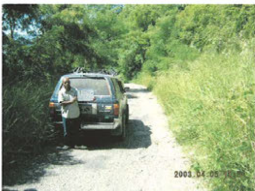
38) 道路状況 (STA115+200)
