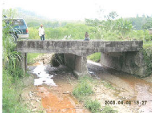
13) コンクリート橋 (STA47+100)
