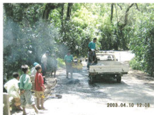
19) 舗装の補修作業 (STA72+300)
