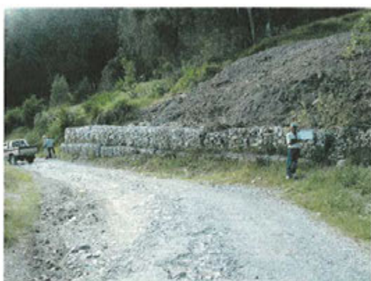
29) 路肩陥没状況 (STA91+370)
