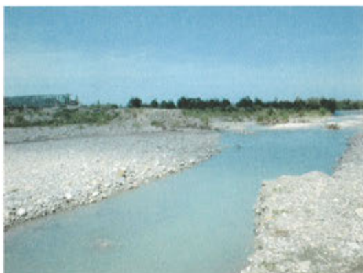
48) モラ橋取付道路流失箇所(STA146+500)
