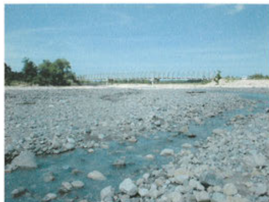
47) モラ橋既設トラス橋 (STA146+000)
