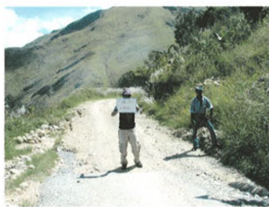
26) 道路状況 (STA86+500)
