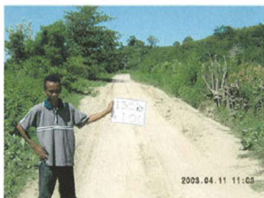
44) 道路状況 (STA135+100)
