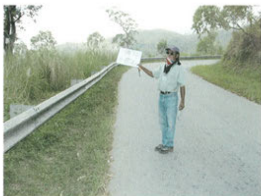
6) ガードレール敷設状況 (STA14+700)
