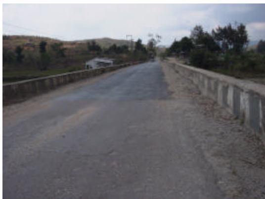
写真 - 2.3 表層改修工 (アイリユウ橋)
