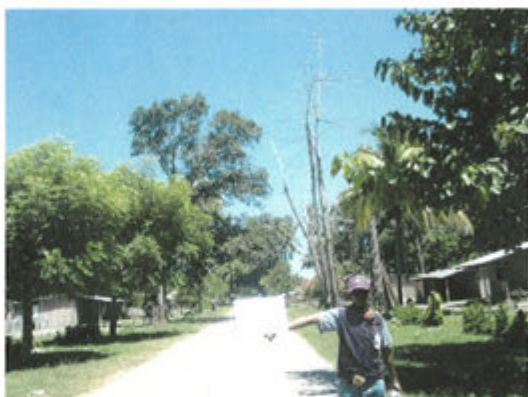
50) 道路状況 (STA155+000)
