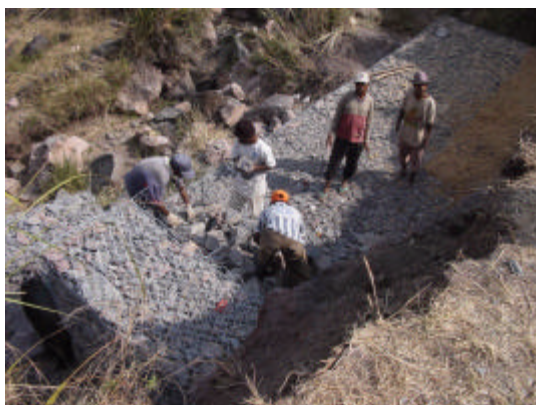
写真 - 2.1 ガビオン工 (km66 + 800)
