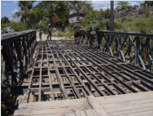
写真 - 2.5 km140 ベイリー橋
