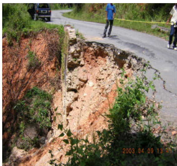
写真 - 3.3 km40+500 付近：谷側斜面の崩壊と自衛隊の復旧状況（現在、完全復旧済）
