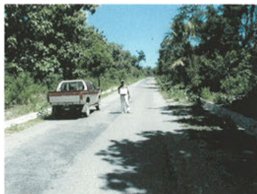
53) 道路状況 (STA170+000)
