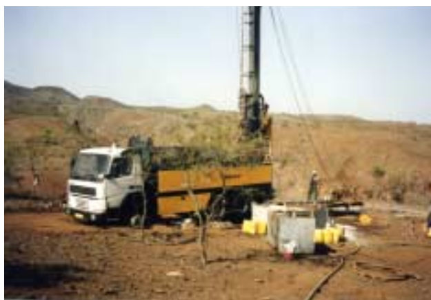
試掘調査実施風景 （計画対象サイト No.26 Dacabalaio）
