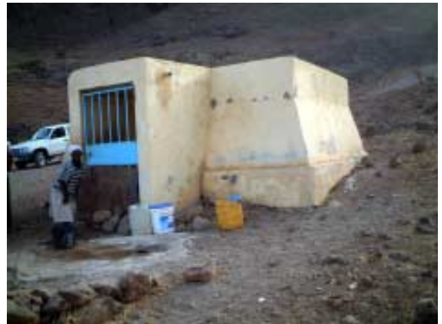
既存公共水栓付水槽 (計画対象サイト No.29 Po de Saco)
