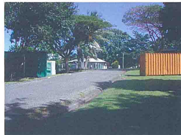
建設用地から見たUSPNet地上局
