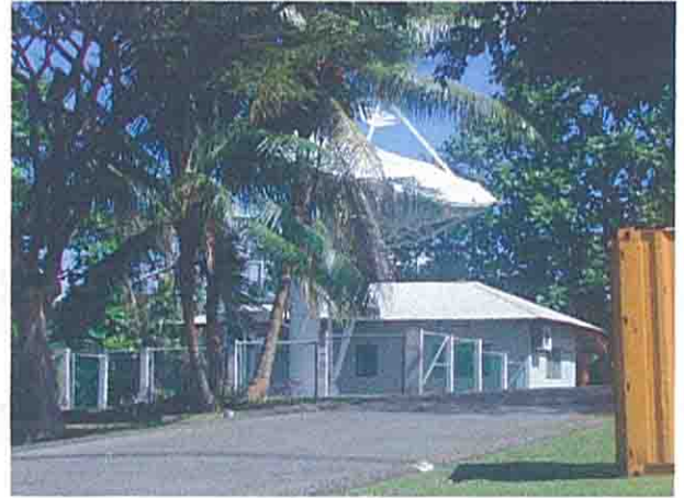
建設用地の隣に位置している地上局
