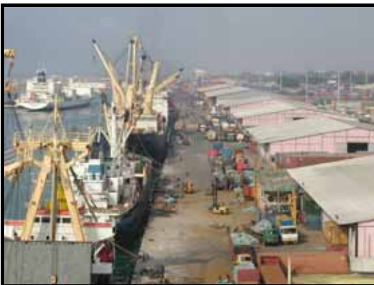
写真 - 29 コト又自治港の岸壁の状況
