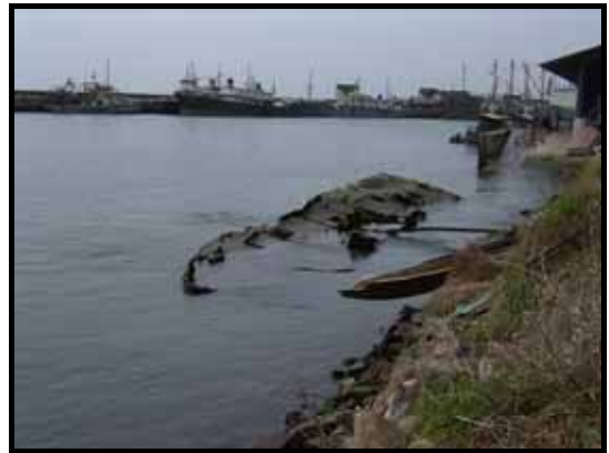
写真 - 28 漁港西側の沈船の状況
