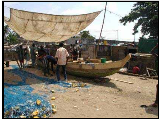
写真 - 18 漁船の修理作業
