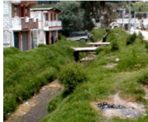
Photo 2.3.7-10 Small canal in La Línea
