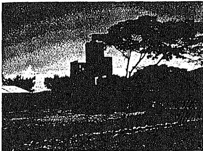
山の湧水を重力式給水方式で貯水するための高架水槽
