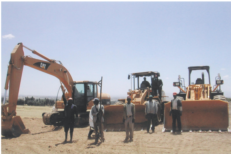
運転操作実地訓練用 OJTサイト内の供与機材
