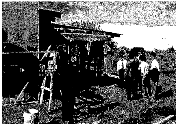
ラ・プラタ大学獣医学部 実験動物舎の増築工事
