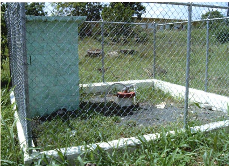
ロス・アティヨスIモデ ル地区水利用及び給水改善パ イロット事業の深井戸試験 掘削（この水源を利用した小 学校への給水をNGOが実施 している）
