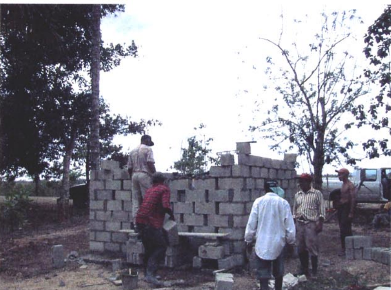
ラ・ルイサモデル地区の給水パイロット事業における受益者グループのポンプ小屋建設
