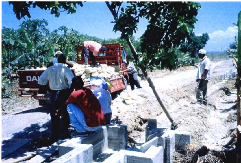
グループD: タマヨモデル地区における農業基盤整備パイロット事業の水路整備工事（労力、現場資材は受益者負担、トラックは運輸業パイロット事業で購入）
