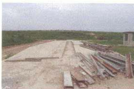
図3-2 処分場入り口のトラックスケール
