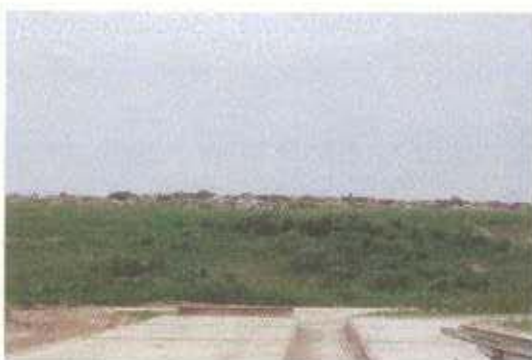
図3-1 Calle100最終処分場遠景
