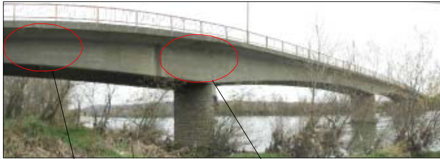
M-1 橋梁全景 (右岸下流側より)
