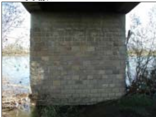
M-6 P1橋脚 自然石で被覆されている
