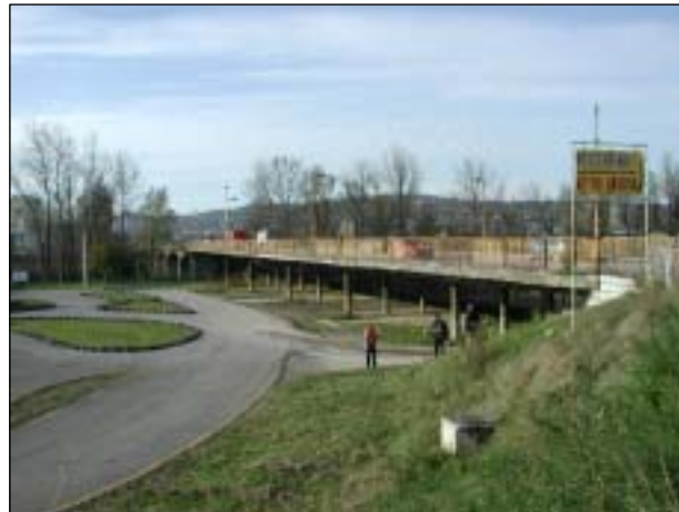
D-02 取付高架部全景
