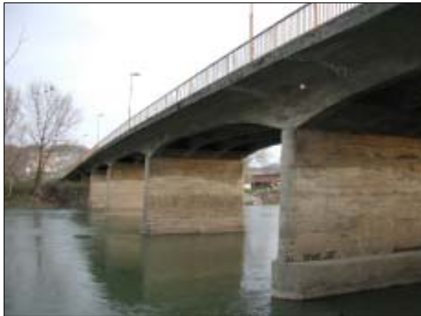
D-01 ボスナ河を渡河する主径間部 (右岸より)
