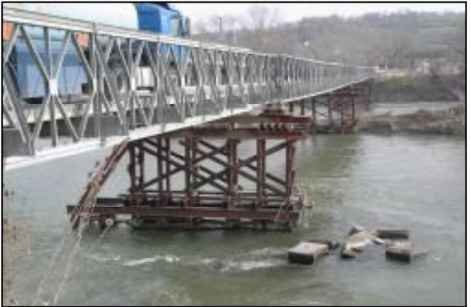
SFORによって架設されたベイリー橋。仮設橋脚基礎の洗掘によりわずかに傾斜が生じ、通行車輛の重量制限を行っている(2003年より)
