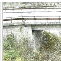
O-4 A2橋台 貼石が施工されている
