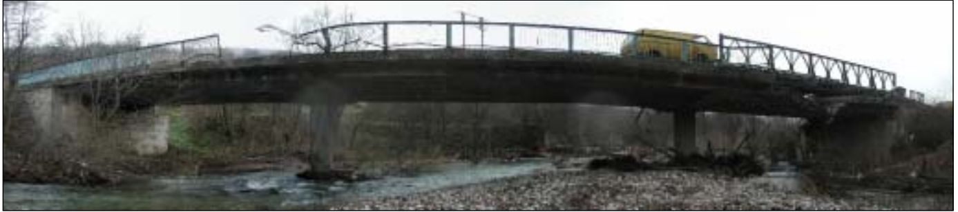
河川上流側より見たボガティチ橋。右がサラエボ方面。
