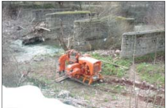
ゼルゼニッチャ川下流に位置する旧橋の橋脚残骸。工事中の交通の切回し道路として仮橋が架けられる計画。
