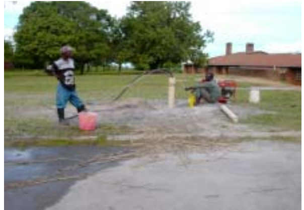
揚水試験実施状況
