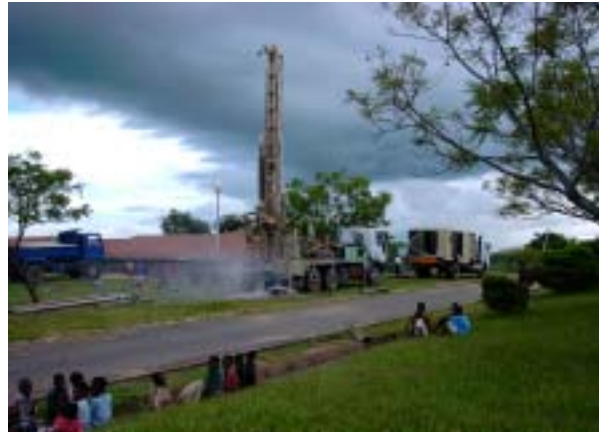
ボアホールのボーリング掘削
