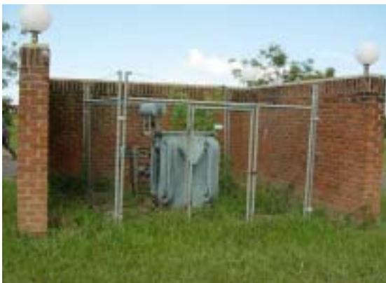
大学敷地内の変電設備。変圧器の容量は200KVAであり現状の使用量に対して余裕がある。
