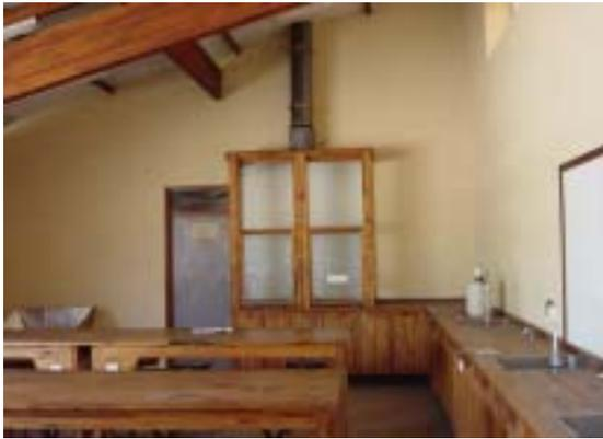
化学実験室の木製ドラフトチャンバー。実験で発生する有害ガスの排気を行う。
