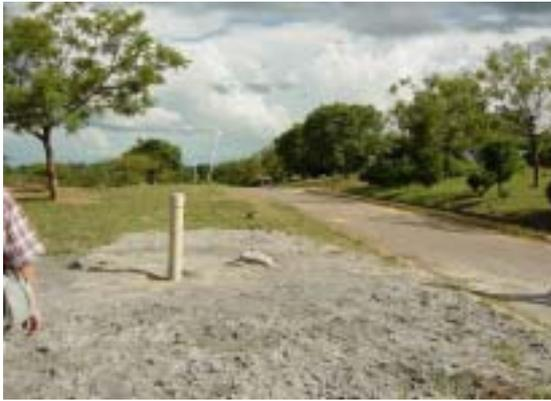
電気探査・試掘による井戸。水量が不足しており、水質も飲料には適さない。
