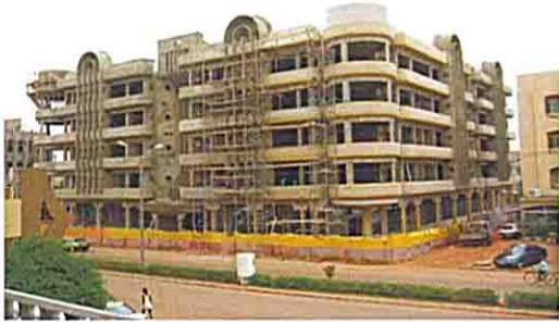
建物 1 (工事現場 1)
