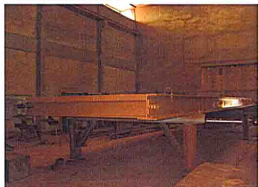
製作中のトラック用スケール架台
