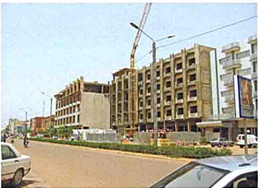
建物 2 (工事現場2)
