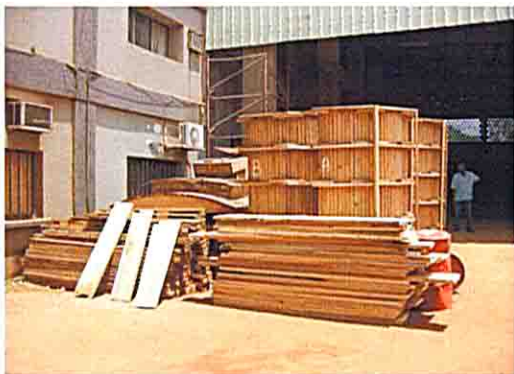
木材、給水塔用型枠
