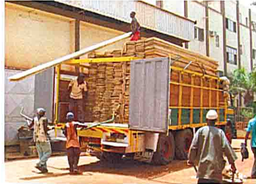
トラックで搬入される材木
