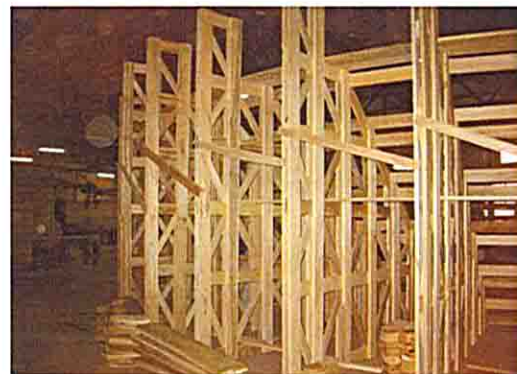
屋内で製作中の給水塔用型枠
