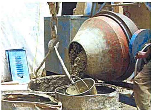
練りあがったコンクリート (工事現場2)
