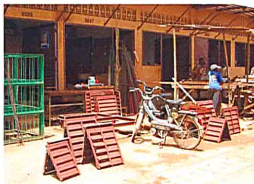
製作中のスチール製建具（1）
