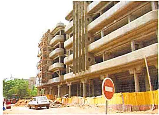
建物 1 (工事現場 1)
