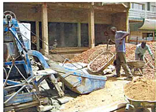
砂利の投入作業 (工事現場2)
