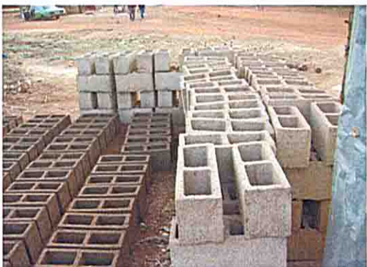
出来上がったコンクリートブロック (工事現場3)
