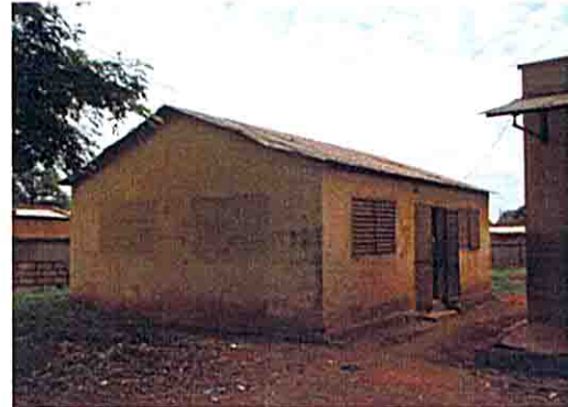
便所を改装して造った教室
