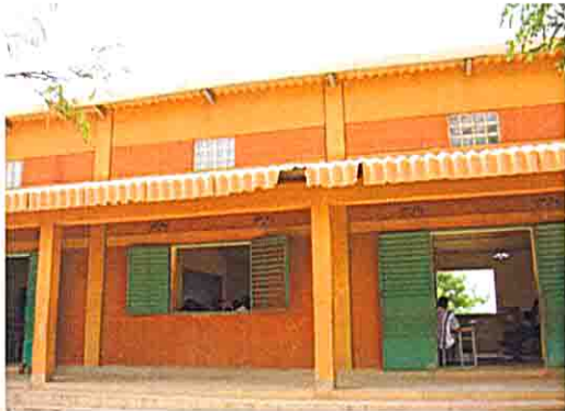
教室棟外観 (外廊下の屋根材の一部が損傷 屋根材：ファイバースメント版) 教室内部
