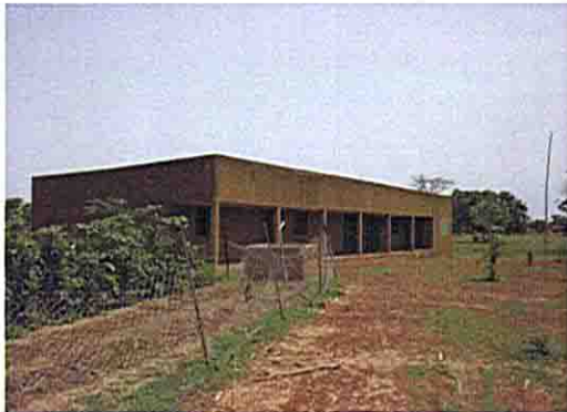
教室棟の全景 (1995年政府資金と地元資金で建設)
