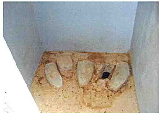
トイレブース内部
