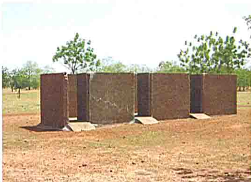
便所 (3ブース、1999年に建設)
