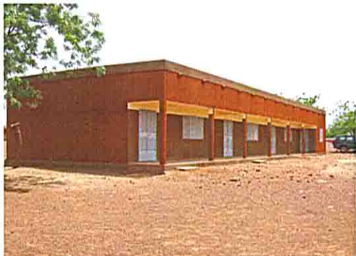
4月着工の新教室棟 (フランス姉妹都市の資金による)
