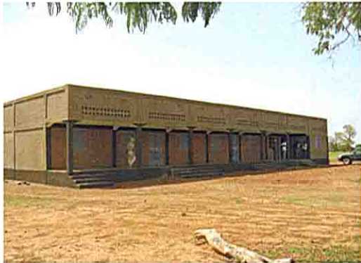
教室棟の全景 (2002年12月完成)
