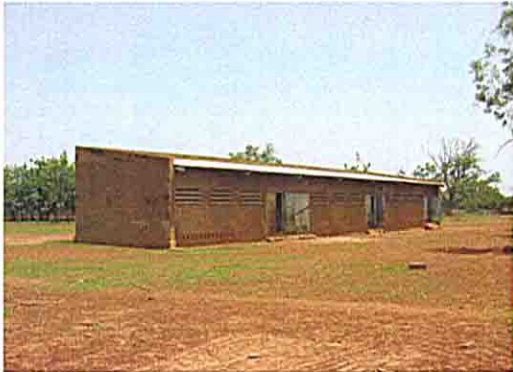
教室棟の全景 (1957年、フランス政府により建設)
