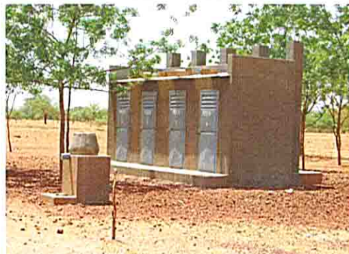
手洗い付便所 (PEEN-Danidaにより建設)
