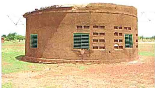
円形教室 (農業倉庫を改修して利用)
