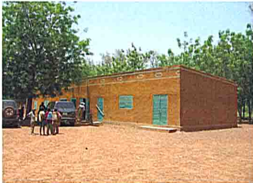
教室棟の全景
