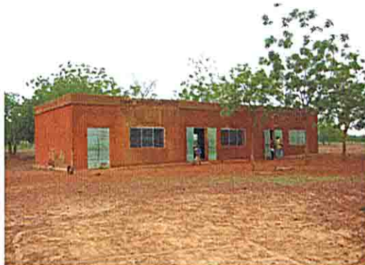
教室棟の全景
