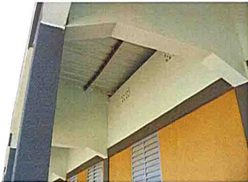
外廊下天井部分
