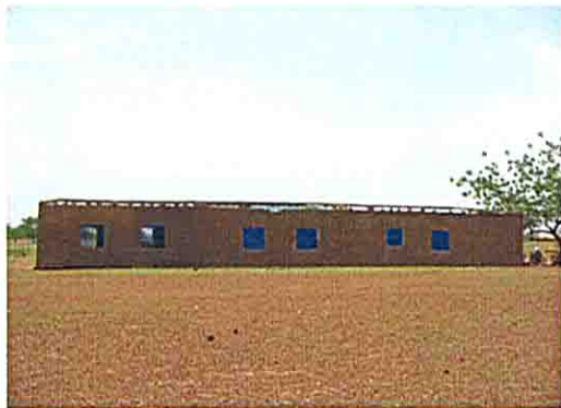
教室棟の全景
