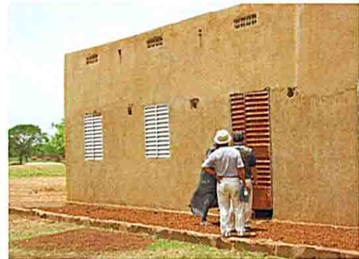
建設中の新教室棟 (2002年工事中断)
