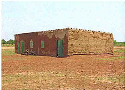
教室棟の全景
