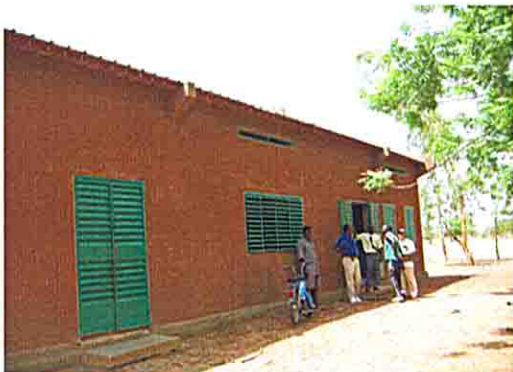
教室棟の外観
