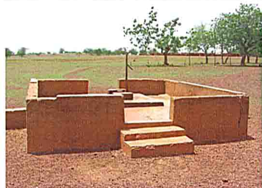
故障中の井戸 (FEDの資金により建設)
