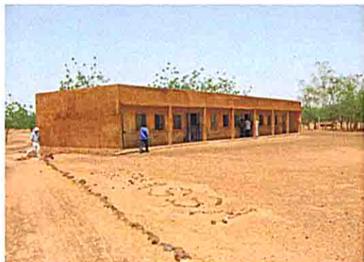
教室棟の全景
