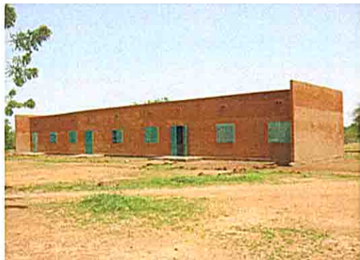
教室棟の全景
