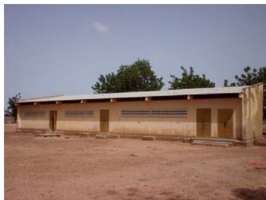
Kourweogo 県 Bousse-A 校。1952年に建設された教室棟。
