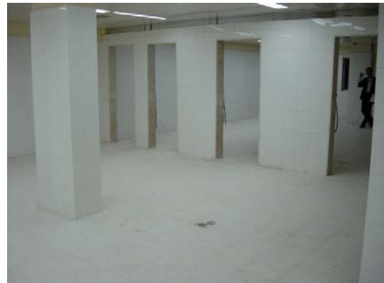
15. BF 中央滅菌室（CLEAN SIDE）
