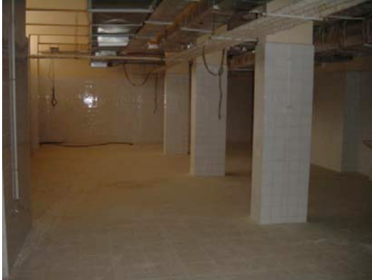
10. BF ランドリー（シーツアイロンの設置予定される部屋）
