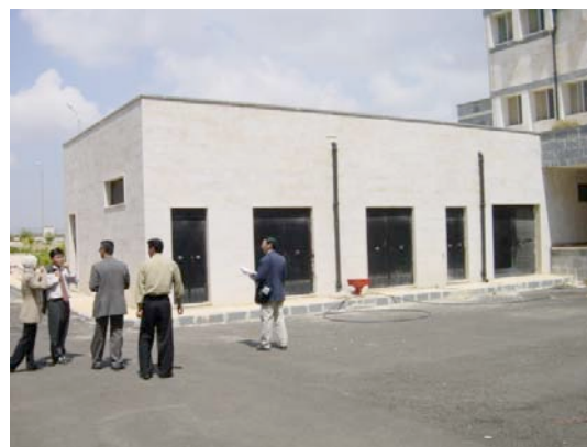
5. 病院の変電設備
