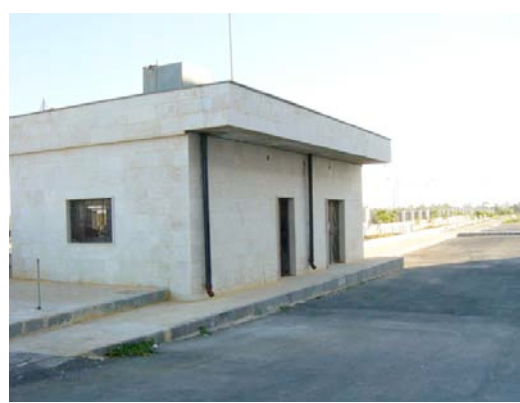
6. 病院の地下水汲み上げポンプ室
