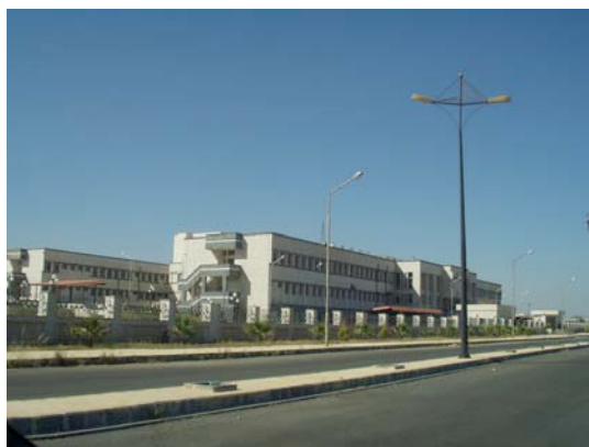
1. ゴラン病院 全景 (正面斜めから)
