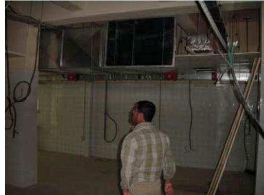
13. BF 厨房内部（天井部は換気用のダクト）
