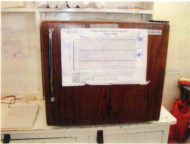
農村保健サブセンター（ワクチン保管用冷蔵庫） 家庭用小型冷蔵庫であるため、停電時はアイスパックの入ったキャリア等に移し換える必要がある。
