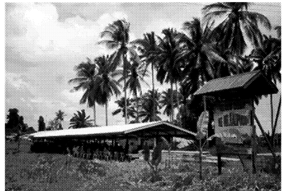
写真11. カリプオン村建設中の市場
