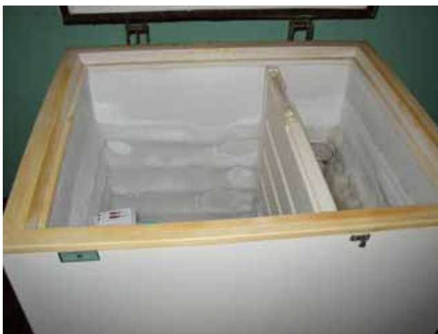
アンティラナナ州保健局の冷蔵庫 氷結しており、数ヶ月に一度霜取りを行わなければならない
