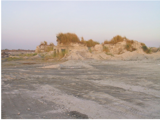
ラハール堆積で埋まった町の コンクリート構築物の跡
