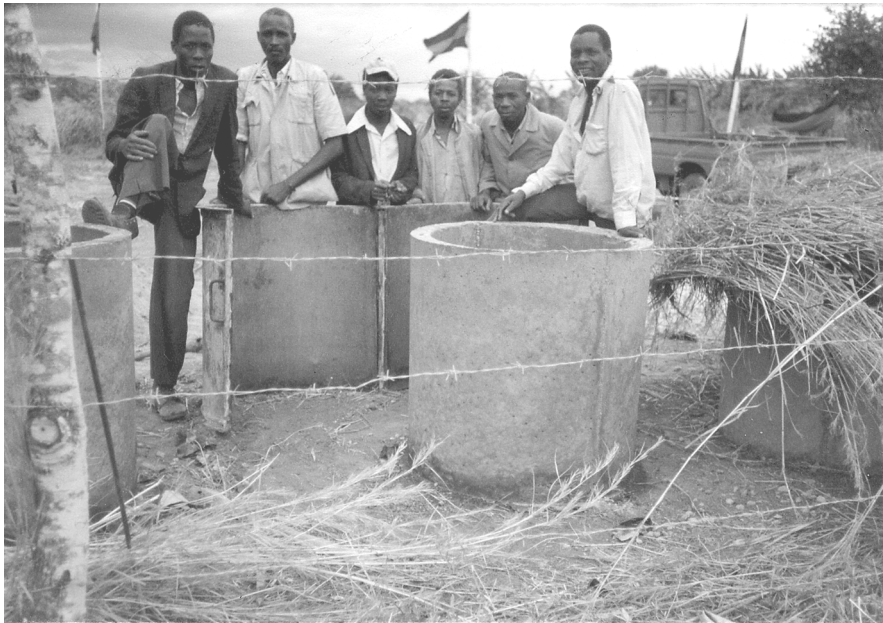
b. 型枠を外したところ
