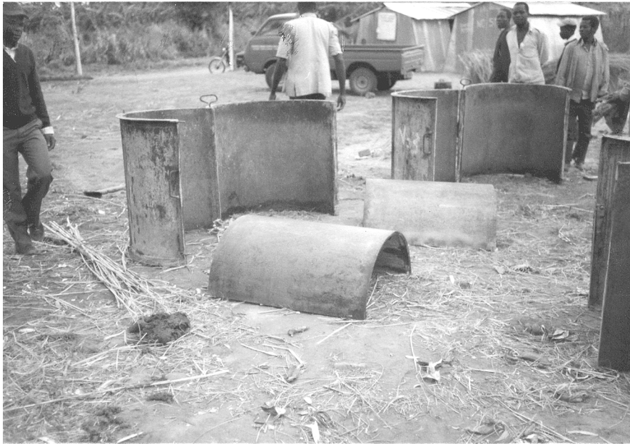
a. コンクリート管の型枠
