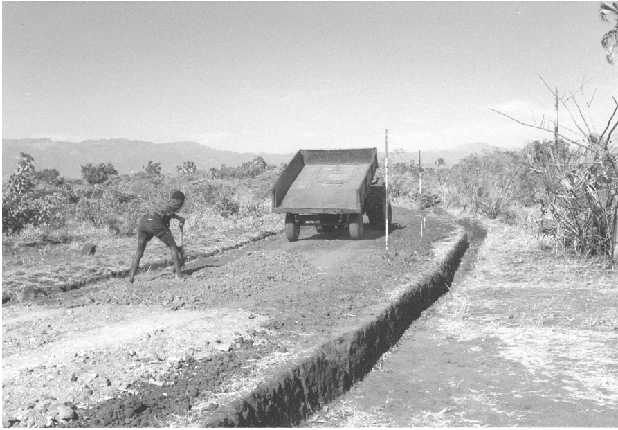
写真 4 - 5 トラクターによる運土
