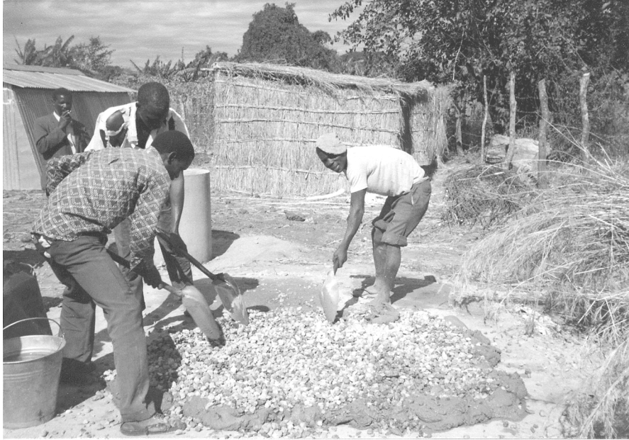
写真4 - 3 コンクリートの手練り(モルタルの上に砂利を広げたところ)
