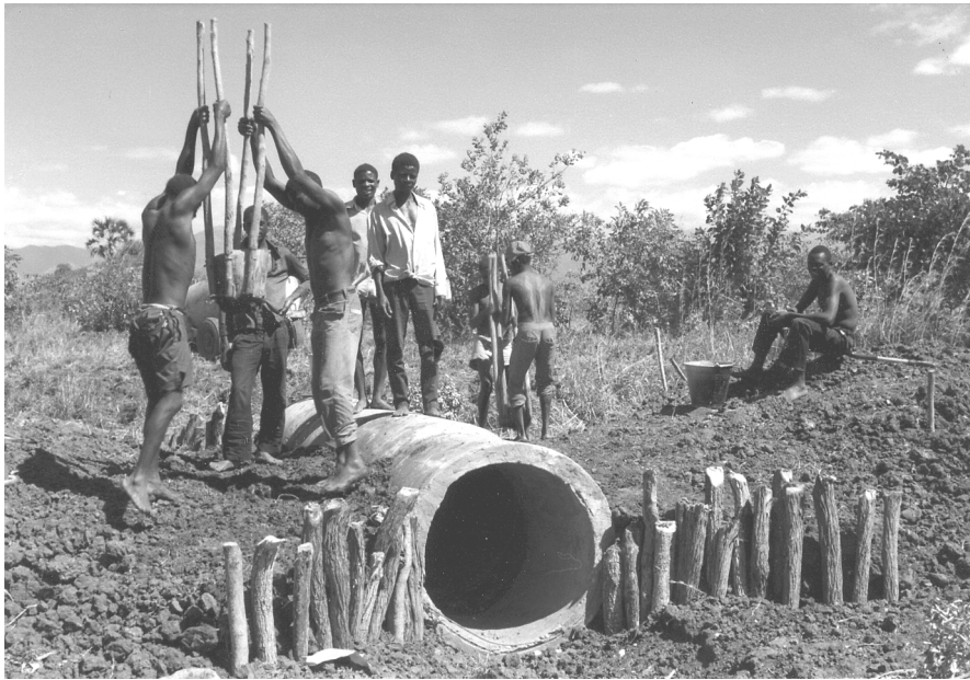
写真 4 - 6 人力タコによる盛り土の締固め
